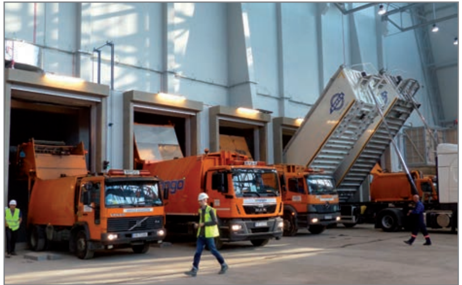
► Fot. 2. Węzeł przyjęcia odpadów
