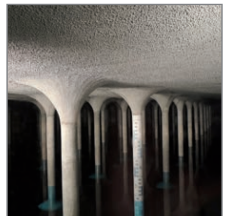
► Wnętrze jednej z komór zbiornika w Budapeszcie.
