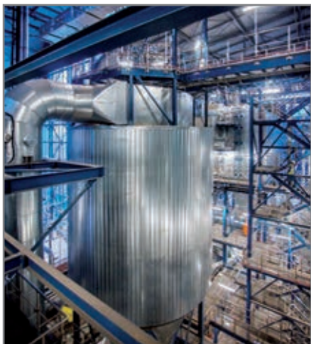
► Fot. 9. Fragment systemu oczyszczania spalin
