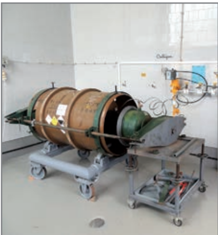
► ZUW w Egerze. Instalacja z chlorem gazowym do dezynfekcji wody.
