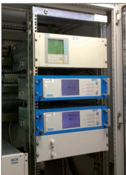
► Fot.10. Aparatura kontrolno-pomiarowa do monitoringu spalin
